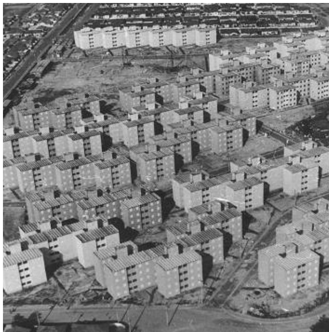
IMAGEM 01 - Modelo de arquitetura e implantação típicos dos projetos financiados pelo Banco Nacional de Habitação, pejorativamente conhecidos como “padrão BNH”.
