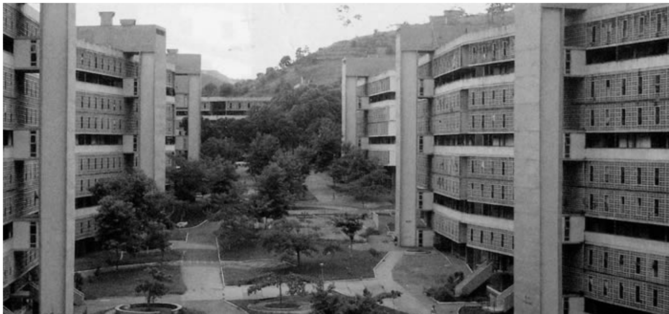
IMAGEM 03 - A qualidade dos espaços abertos se dá pela variação de escala das áreas de convívio e agradabilidade dos espaços devido às áreas verdes que se estendem pelo terreno do Conjunto.
