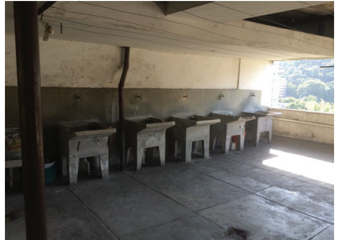
IMAGEM 3 - Lavanderia construída no último pavimento do bloco 1, voltada para Norte.
