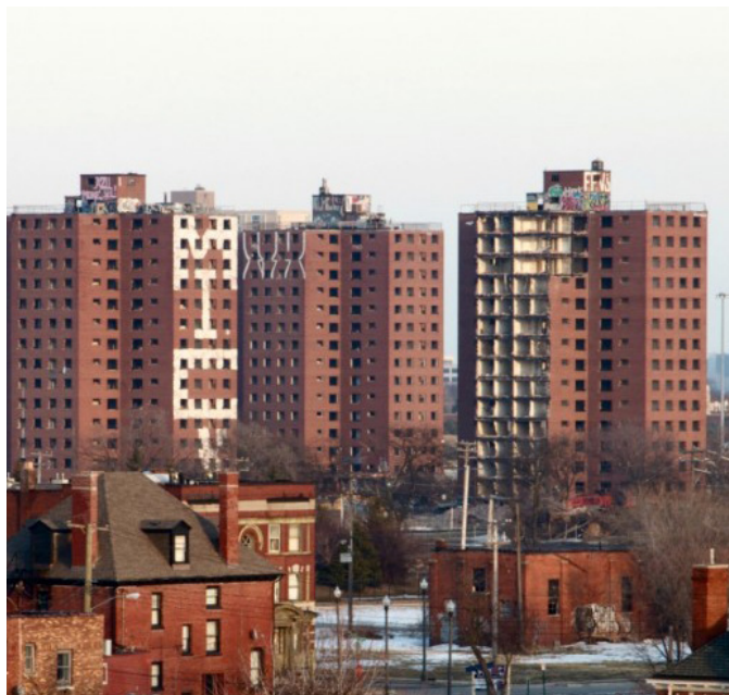
IMAGEM 13 - Torres do Brewster degradadas.
